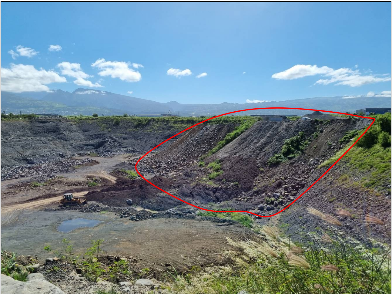
Remblais inertes déversés dans le casier actuel - Instable
