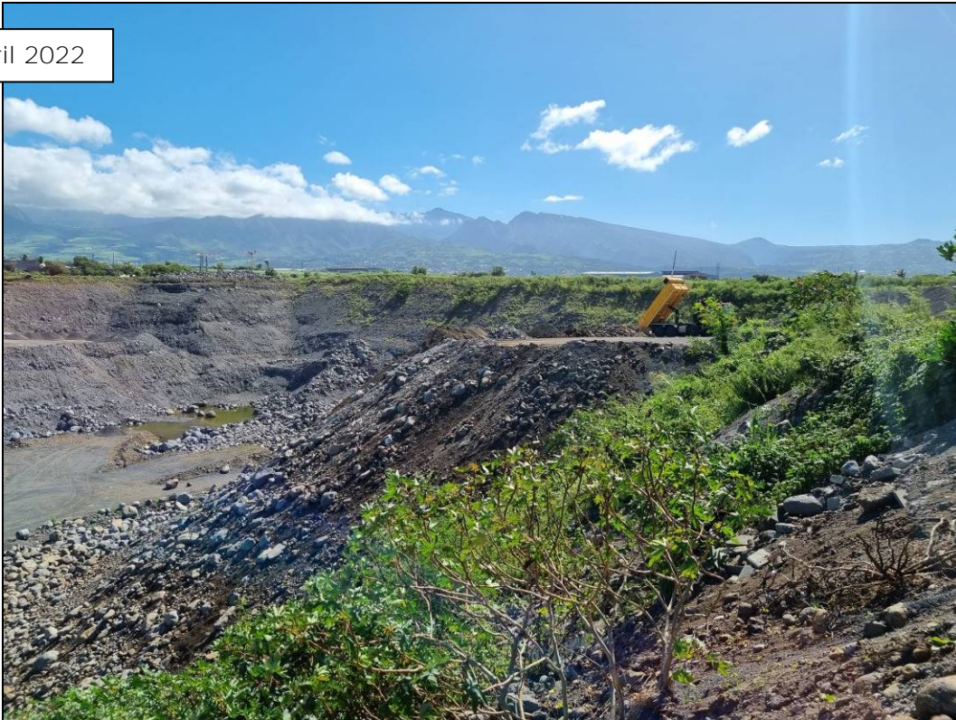
Talus Sud Est - Présence de remblai inerte (non compacté)
