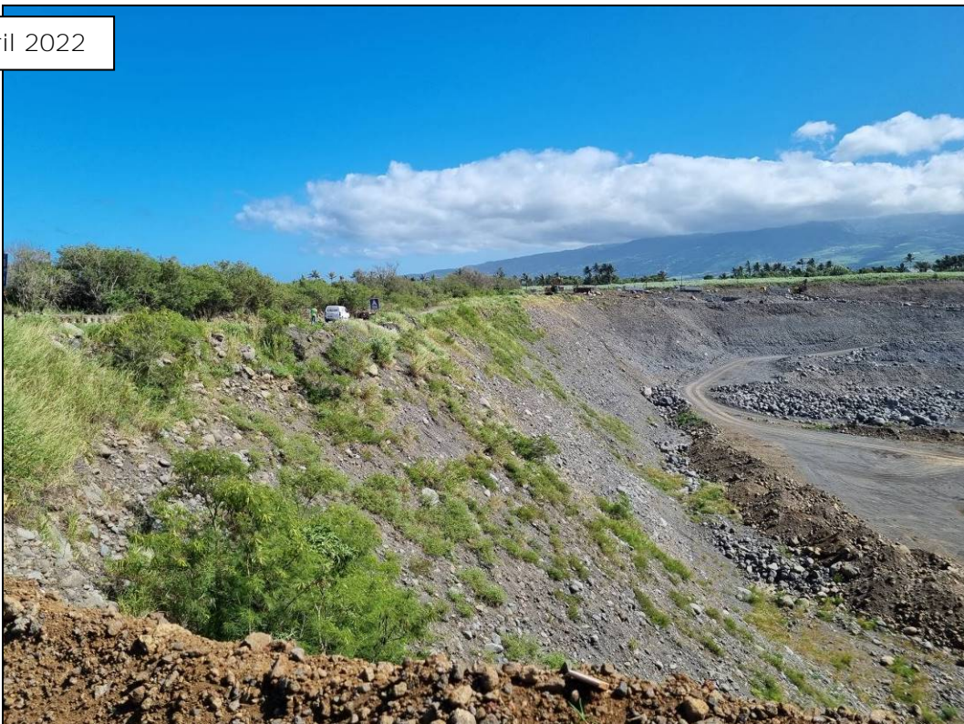
Talus sud-ouest (1H/1V)
